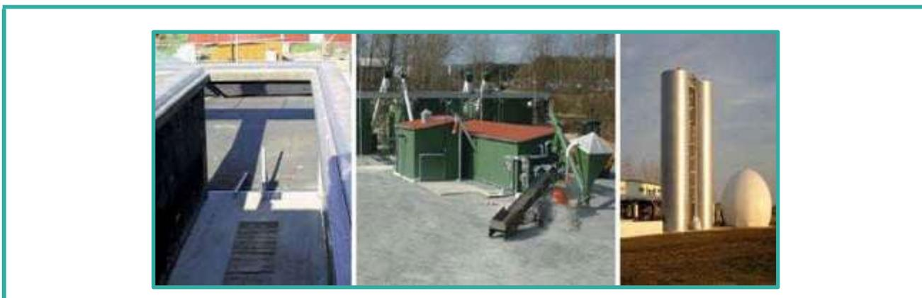
Exemplos de configurações especiais na fermentação a seco; reator sequencial em batelada (esquerda), biodigestor de baia com agitador (centro), estágio de metanização da digestão seca/úmida e gasômetro externo (direita)
