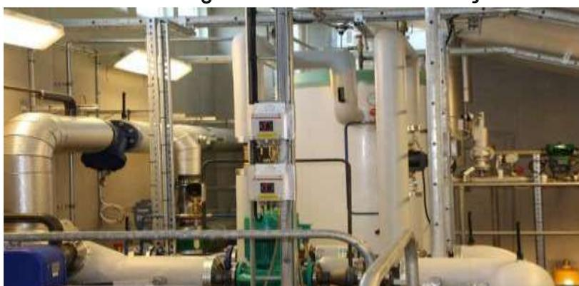
7.6.6. Pré-tratamento de gás. O biogás com a biomassa do coco verde, que é composto, em sua maior parte, por metano e gás carbônico, ao sair do digestor está saturado com água e possui também um percentual pequeno de H<sub>2</sub>S (ácido sulfídrico), oxigênio, nitrogênio, hidrogênio e algumas impurezas. Para melhorar a qualidade do gás e também
