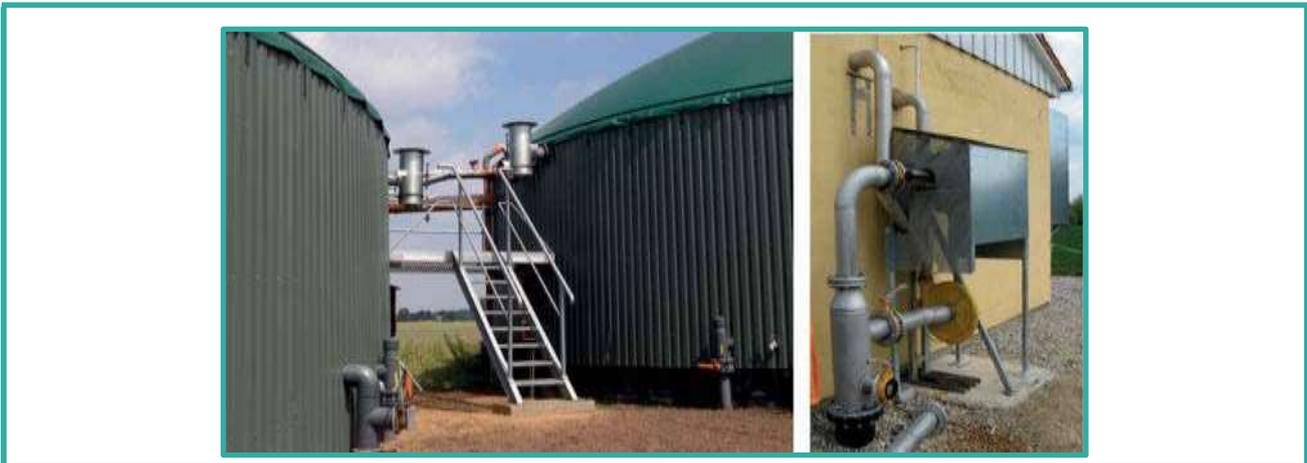
Plataforma de trabalho entre dois reservatórios com tubulação e dispositivos de alívio de pressão (esquerda); tubulação de gás com soprador compressor
