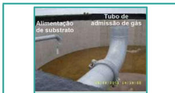
Dispositivos para transportar o gás sem distúrbios; tubo de admissão de gás com abertura voltada para cima
