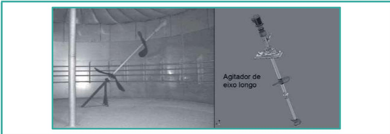
Agitadores de eixo longo com dois dispositivos de agitação, com e sem apoio no fundo do biodigestor
