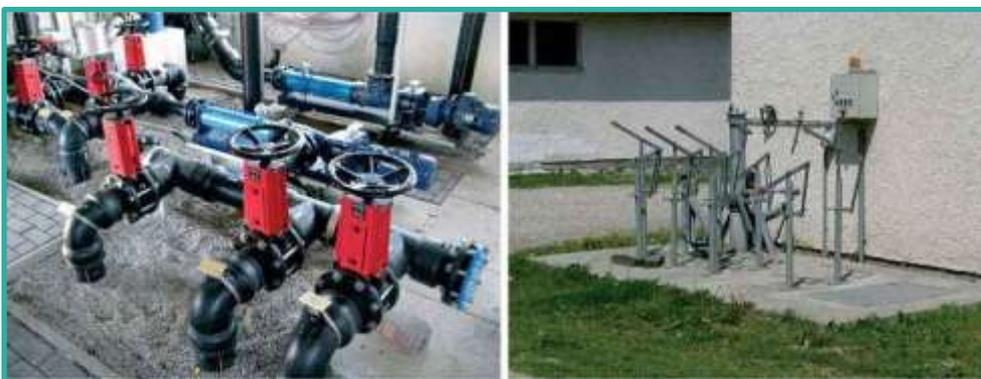
Tubulações e válvulas em uma estação de bombeamento, válvulas de gaveta
