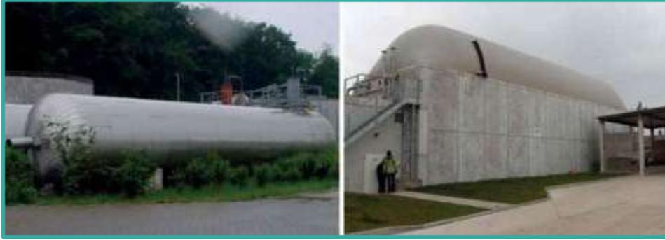
Biodigestor de fluxo pistonado; exemplos práticos, cilíndrico (esquerda), retangular, com gasômetro montado no topo (direita)
